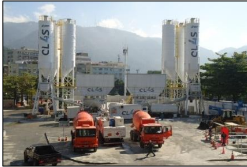
Central de concreto na obra
